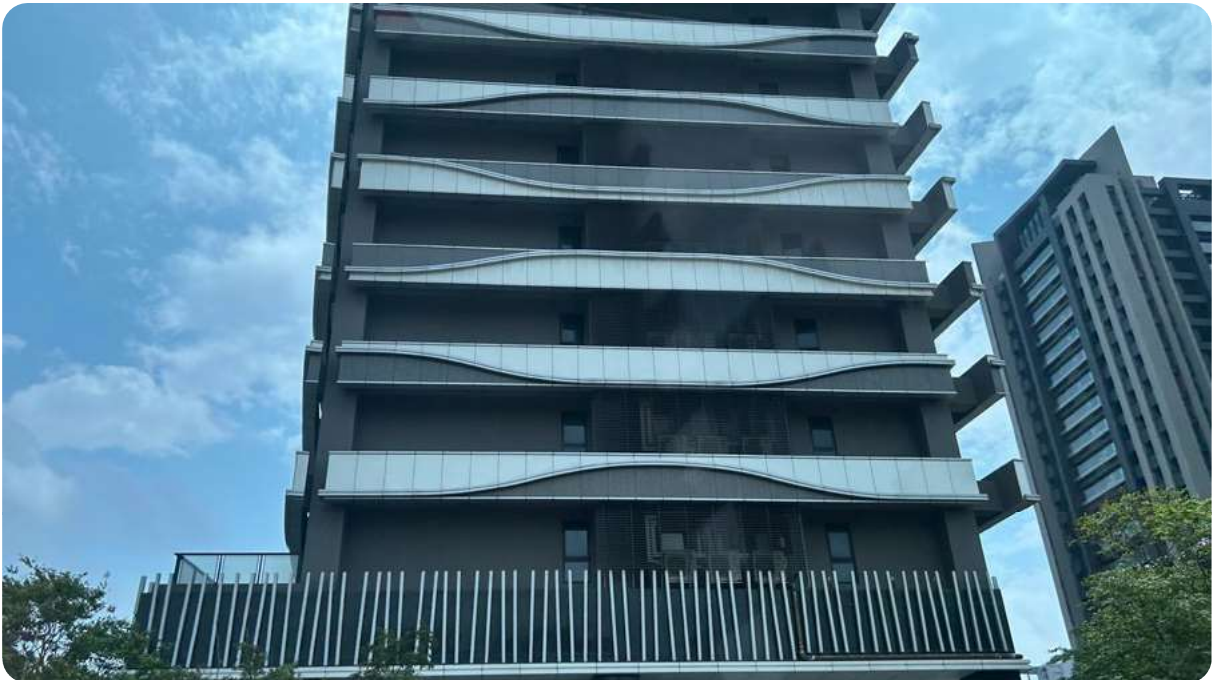
▲ CNS 2253 A3004P-O 帷幕牆用鋁材料
