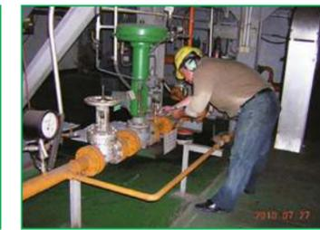
使用超音波氣體洩漏偵測器進行節能查漏
