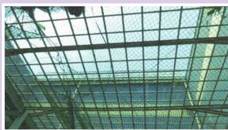
增設安全母索及安全網防止墜落
