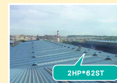
L3 廠房抽風機
